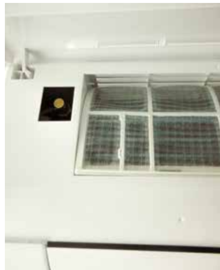
Valvola di spurgo aria - Air purge valve
